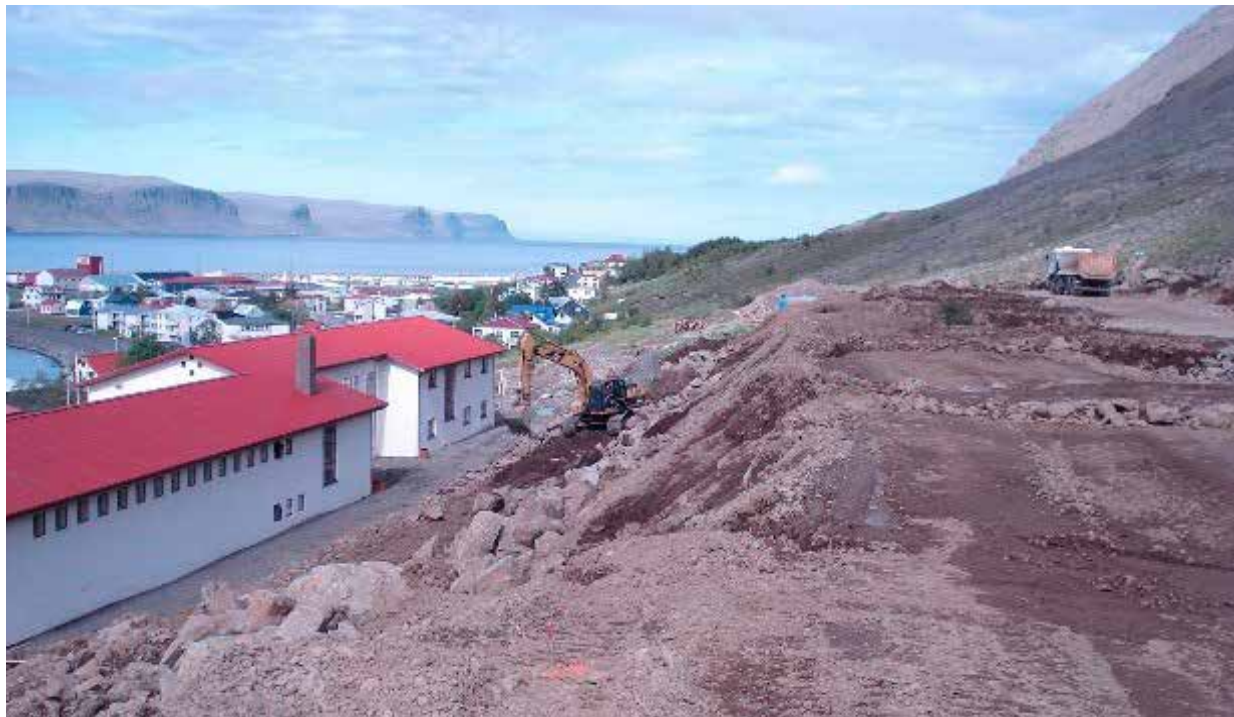
Mynd 1. Grundun þvergarðs ofan við grunnskólann á Patreksfirði.
