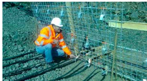
Mynd 7. Fulltrúi frá Reinforced Earth leiðbeinir við uppsetningu styrkingarkerfisins.
