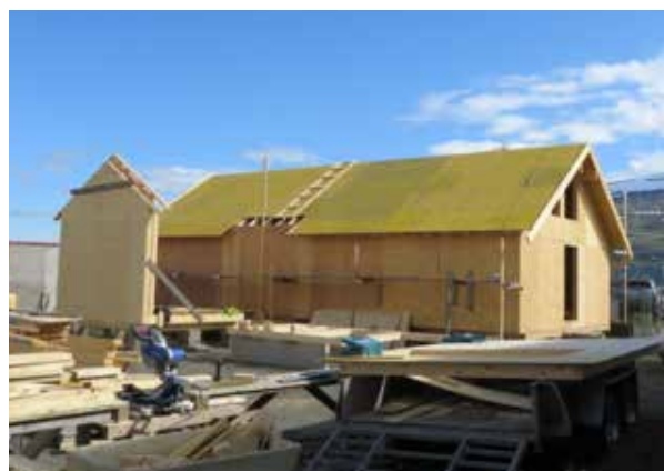
Mynd 6. Framkvæmdir 10. júní 2014.
