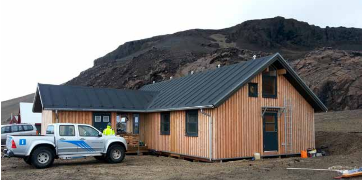
Mynd 1. Drekgil – Landvarðarhús.
