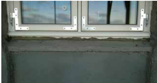
Mynd 7. Nýr gluggi kominn í og búið að ganga frá ytri þéttingum. Vatnsbretti hefur verið endursteypt.
