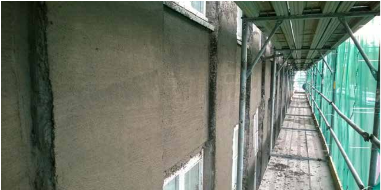
Mynd 6. Múrviðgerðir og endursteyning.
