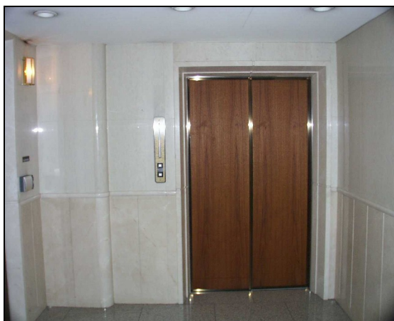
Hol við lyftu - fyrir breytingu.
