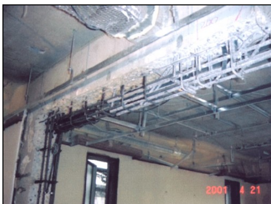
Burðarbitar voru styrktir og settir nýir.
