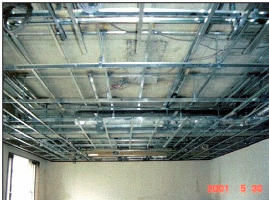
Loft voru tekin niður í móttökustofum.
