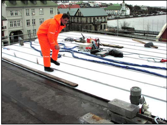
Unnið við frágang á þaki.
