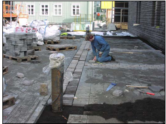
Unnið við hellulögn vestan við þjónustuskála.
