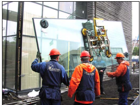
Unnið við glerjun.
