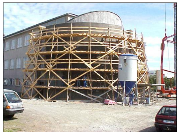
Unnið við 1. áfangi.
