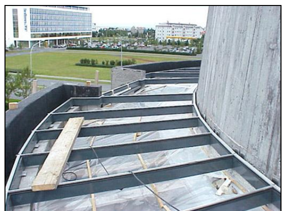
Unnið við þak forskála.
