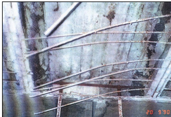
Mynd 20 : Skemmdir í lofti yfir fjölnotasal á 3. hæð.
