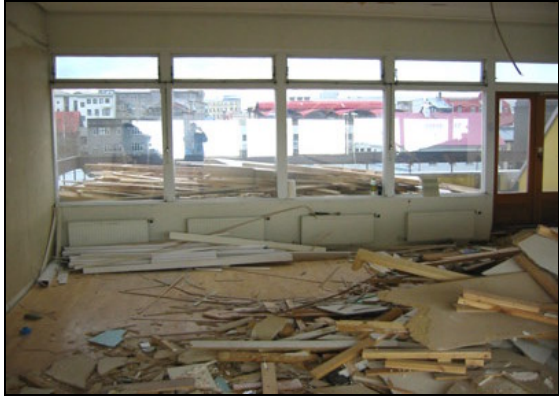
Talsvert rif var í upphafi framkvæmdar.
