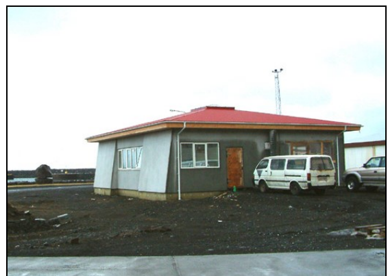
Húsið á byggingarstigi.
