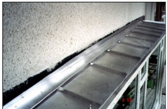
Lagfæring á kraga yfir glugga.
