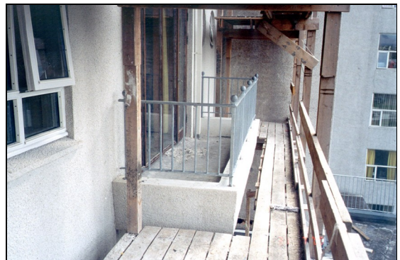
Lagfæringu svala lokið og komið upp nýtt handrið.
