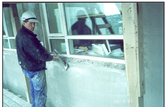
Unnið við endursteyningu.
