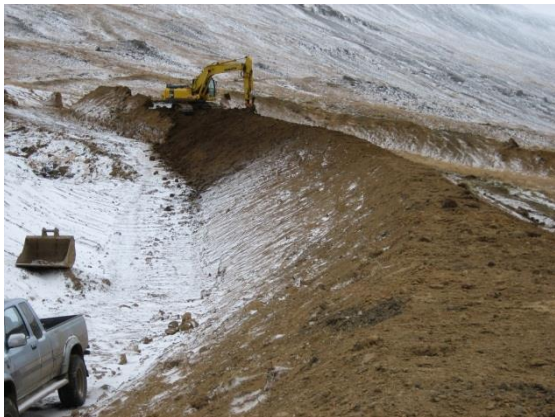
Mynd 4: Framkvæmdir við uppbyggingu garðanna
