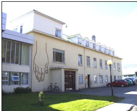
Fjórðungssjúkrahúsið í Neskaupstað fyrir breytingu.
