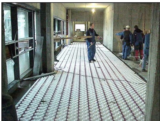
Lagðar hitalagnir í gólf. Mynd frá nóvember 2001.
