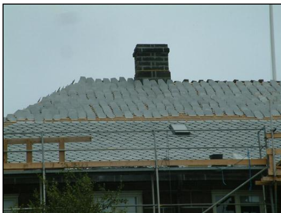
Þaksteinslögn mátuð með röðun á langbönd.
