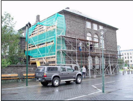
Verkpallar settir upp á suður- og austurhlið.
