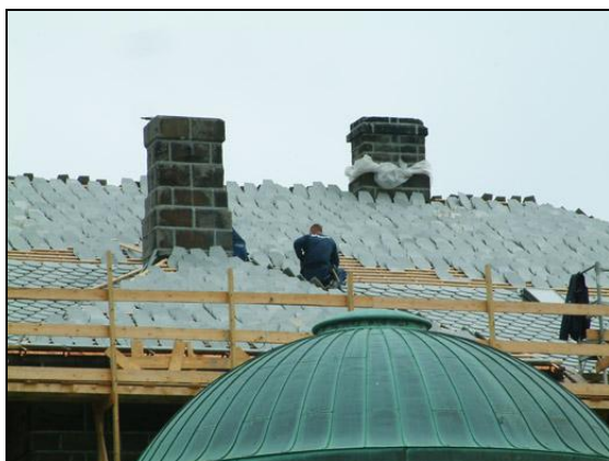
Unnið að lagningu þaksteins á sunnanvert þakið.
