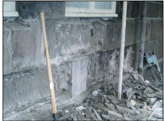
Unnið við að fjarlægja ytra byrði steina á austurhlíð.
