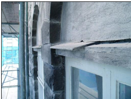
Vatnsbretti úr skífu yfir glugga úr þakskífufelni.
