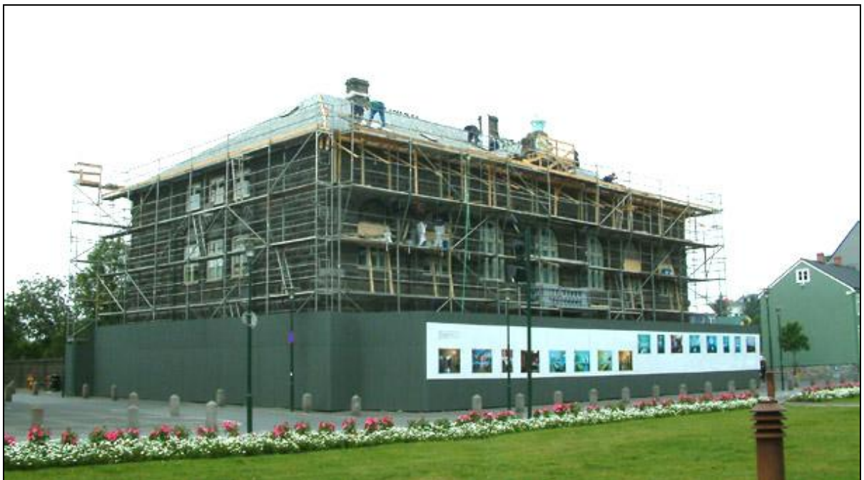
Verkpallar og girðingar við norður -og austurhlið.
