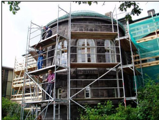
Verkpallar við Kringlu.
