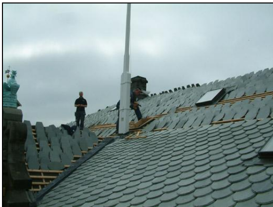
Unnið við lagningu þaksteins norðanmegin.
