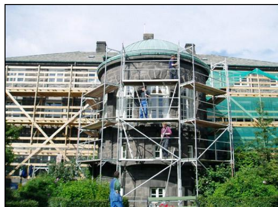
Viðgerðir á suðurhlið í júlí 2003.
