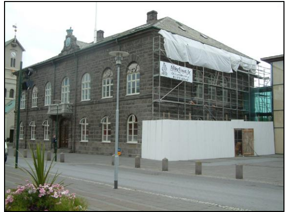
Verkpallar og girðing við vesturhlið.
