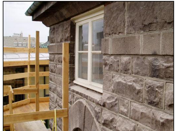
Viðgerð á útvegg á 3. hæð suðurhliðar.
