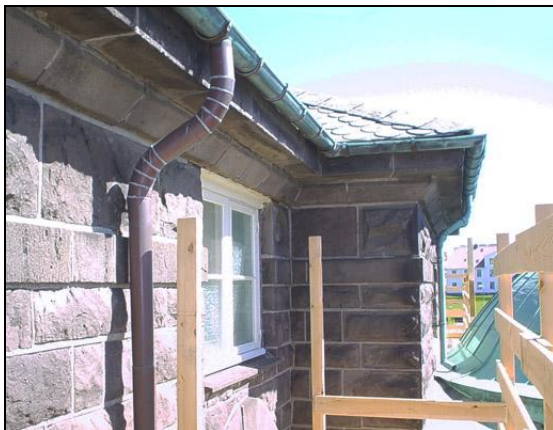
Unnið við þakbrún á suðurhlið.
