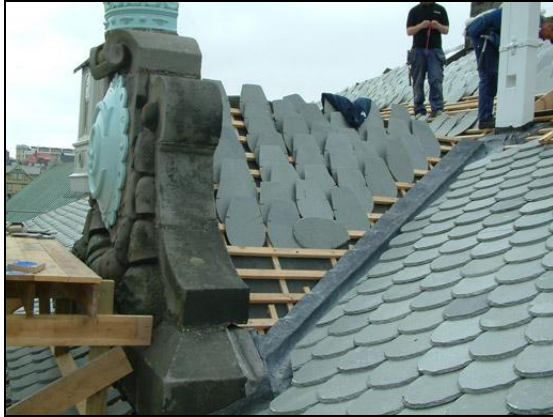
Unnið við lagningu þaksteins á þakspíss.
