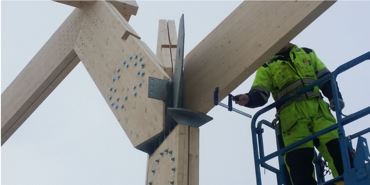
Mynd 2. Á byggingartímanum.
