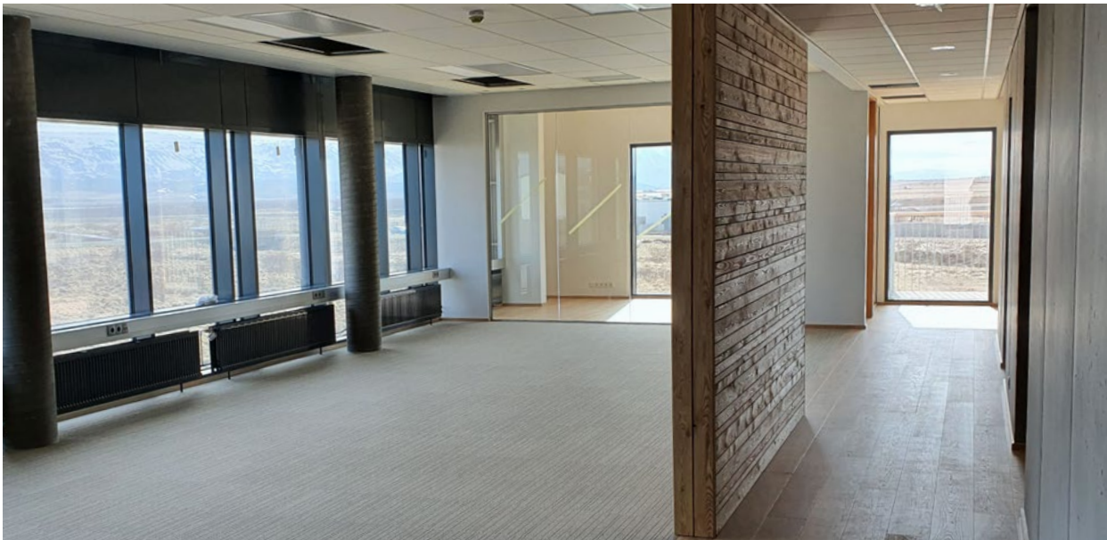
Mynd 6. Framkvæmdir innanhúss.
