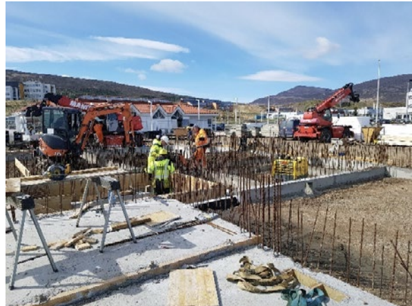
Mynd 3. Unnið við byggingu sökkla.
